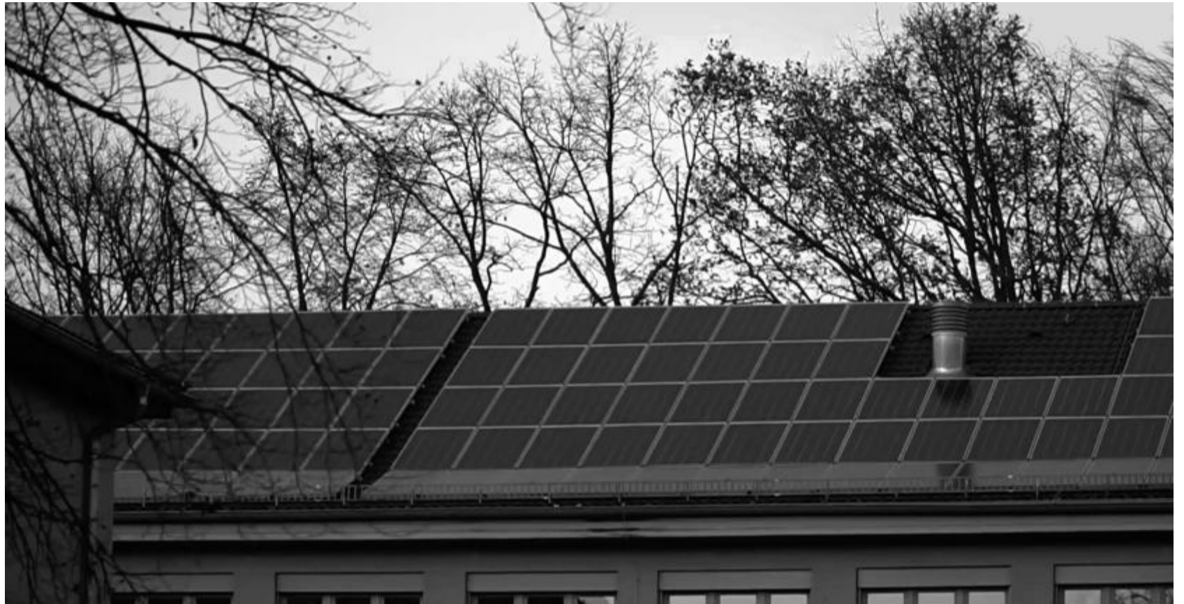
▲ Die 2010 installierte Photovoltaik Anlage auf einem Gebäude der Universität Potsdam soll Studierenden und Mitarbeiter*innen die Umsetzung der Idee regenerativer Energien ganz praktisch näher bringen.
